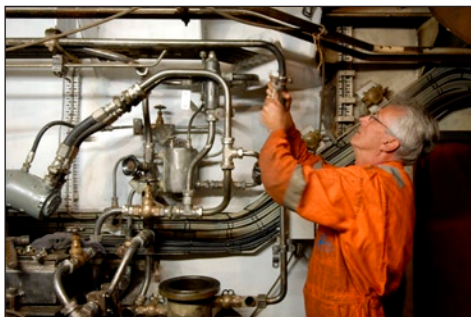
Aad Ouwendijk sluit de pompen aan.
