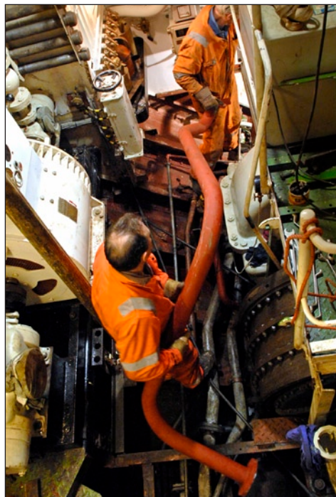
Het leidingwerk weer terug in de machinekamer.
